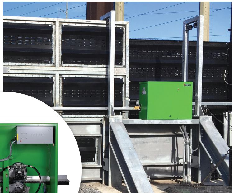
SlideDriver 200 opera una puerta contra impactos en la subcentral eléctrica
